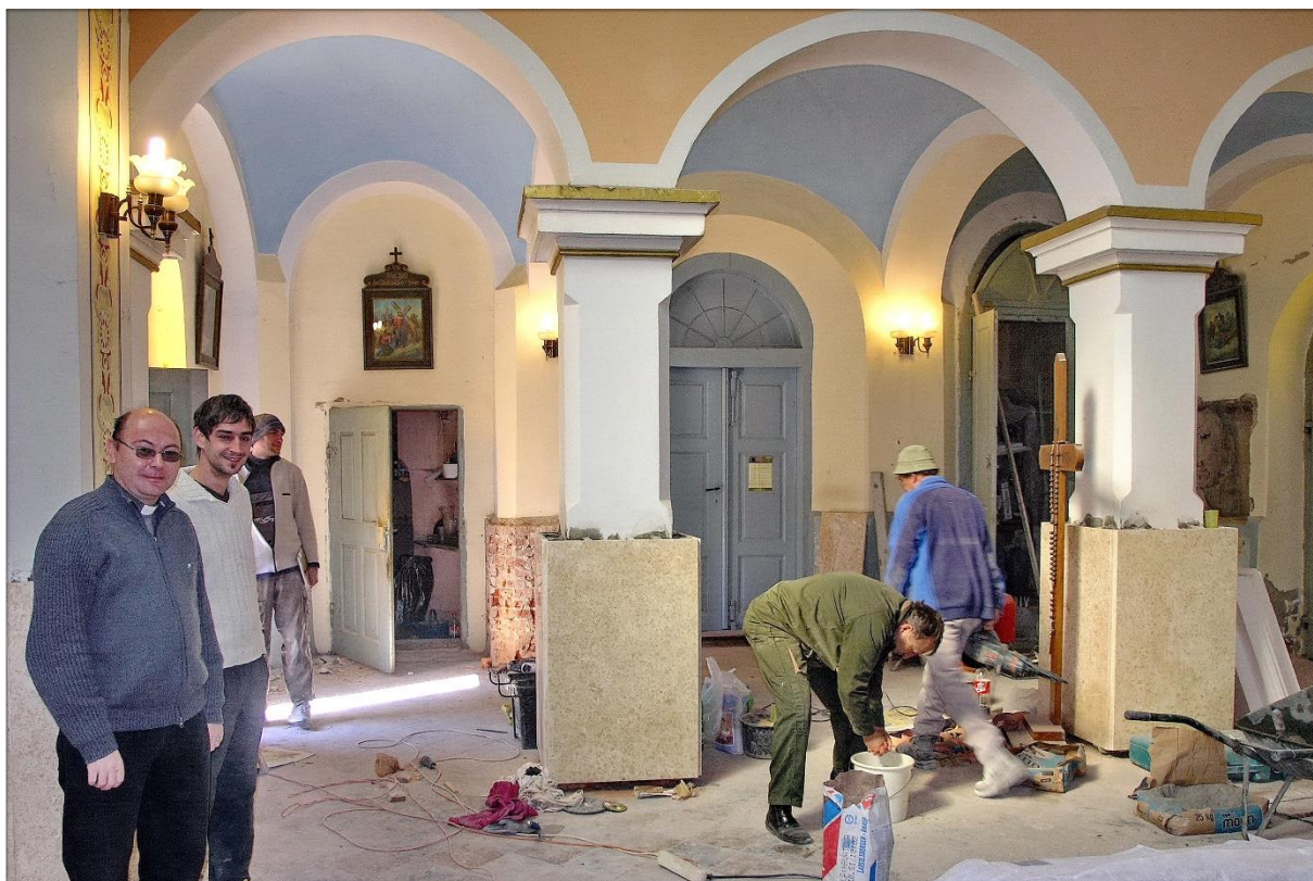
Radovi na uređenju unutrašnjosti crkve u ožujku 2011. godine.
